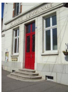
réhabilitation école communale (2011) et périscolaire (2015)
