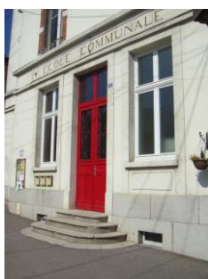
réhabilitation école communale (2011) et périscolaire (2015)
