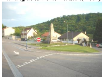
Aménagement carrefour Rue de Gorze (2005)
