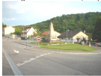
Aménagement carrefour Rue de Gorze (2005)
