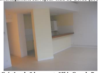
Création de 3 logements 98bis Grande Rue (2004)
