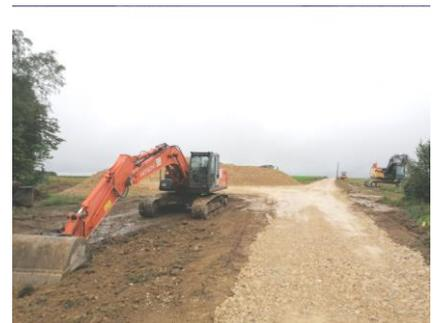
Un travail de dessouchage a été effectué préalablement jusqu'à la carrière d'Arnaville. Une emprise de 10ml et un empiérement de 3.5 m permettra la circulation. Une place de retournement et une zone de stockage ont été réalisées.
