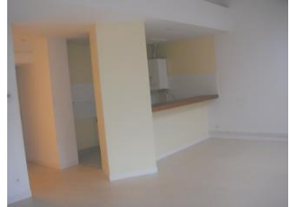
Création de 3 logements 98bis Grande Rue (2004)
