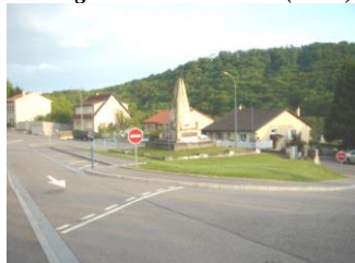
Aménagement carrefour Rue de Gorze (2005)
