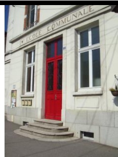
réhabilitation école communale (2011) et périscolaire (2015)
