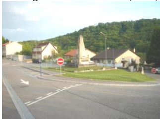
Aménagement carrefour Rue de Gorze (2005)
