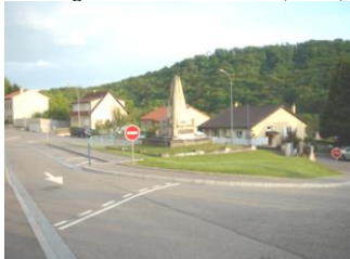
Aménagement carrefour Rue de Gorze (2005)
