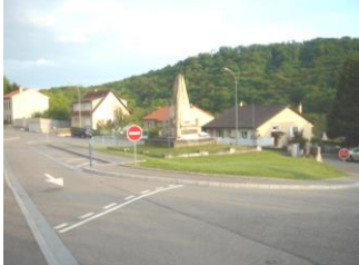
Aménagement carrefour Rue de Gorze (2005)
