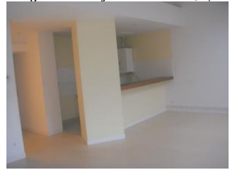
Création de 3 logements 98bis Grande Rue (2004)
