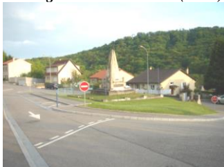
Aménagement carrefour Rue de Gorze (2005)
