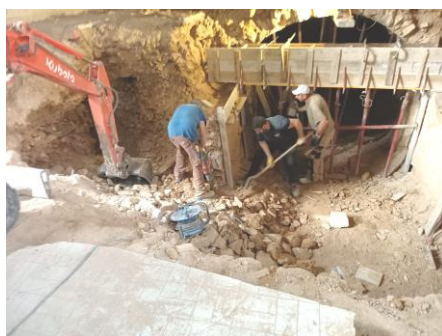
Préparation cage ascenseur : travaux en sous-sol
