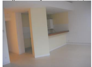
Création de 3 logements 98bis Grande Rue (2004)
