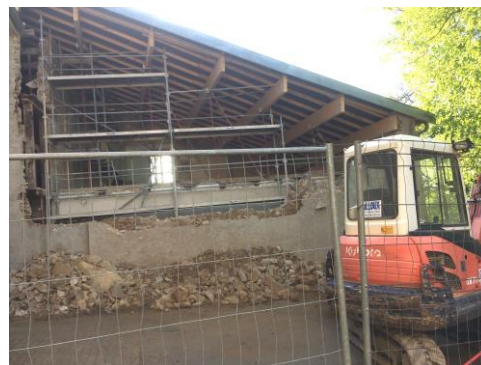
Pignon ouest complètement déconstruit
