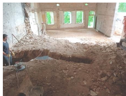
Bâtiment entièrement vidé de ses anciennes structures
