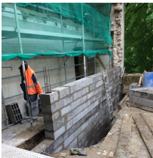
Reconstruction du pignon avec fondations réalisées dans la cave voûtée
