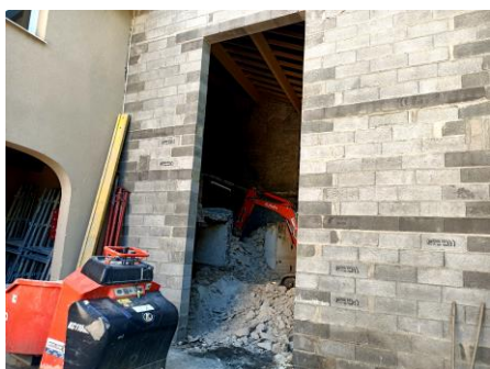
Porte d'entrée future dans pignon ouest
