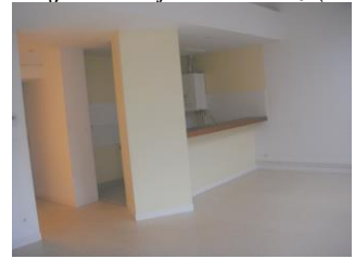
Création de 3 logements 98bis Grande Rue (2004)
