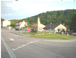
Aménagement carrefour Rue de Gorze (2005)
