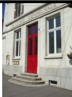
réhabilitation école communale (2011) et périscolaire (2015)
