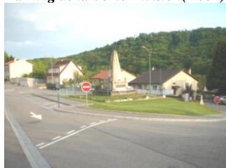
Aménagement carrefour Rue de Gorze (2005)
