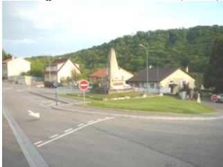
Aménagement carrefour Rue de Gorze (2005)
