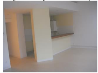
Création de 3 logements 98bis Grande Rue (2004)
