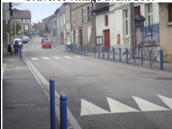
Traverse village actuelle voitures sur la chaussée, piétons à l'abri sur les trottoirs
