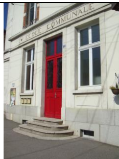
réhabilitation école communale (2011)
