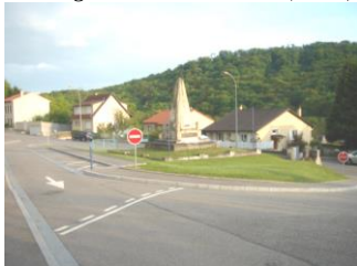
Aménagement carrefour Rue de Gorze (2005)
